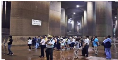
首都圏外郭放水路
